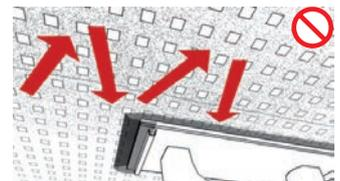
Humidifier légèrement la zone de jointure avec une éponge, mais veiller à ne pas trop mouiller les plaques acoustiques design.
