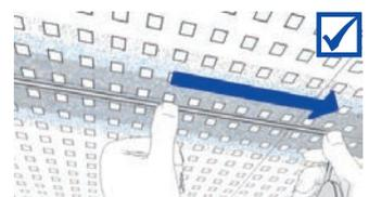
Ensuite, recouvrir la zone de jointure d'une épaisse couche de colle liquide, ne passer le rouleau en peau d'agneau sur la surface du plafond qu'avec une légère pression.
